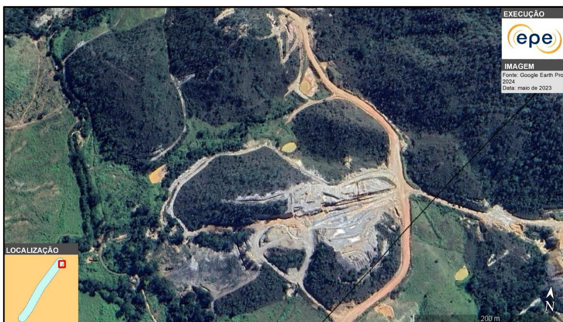
Figura 40 – Cava de mineração em área de relevo movimentado, em região do entorno da área urbana de Niquelândia
