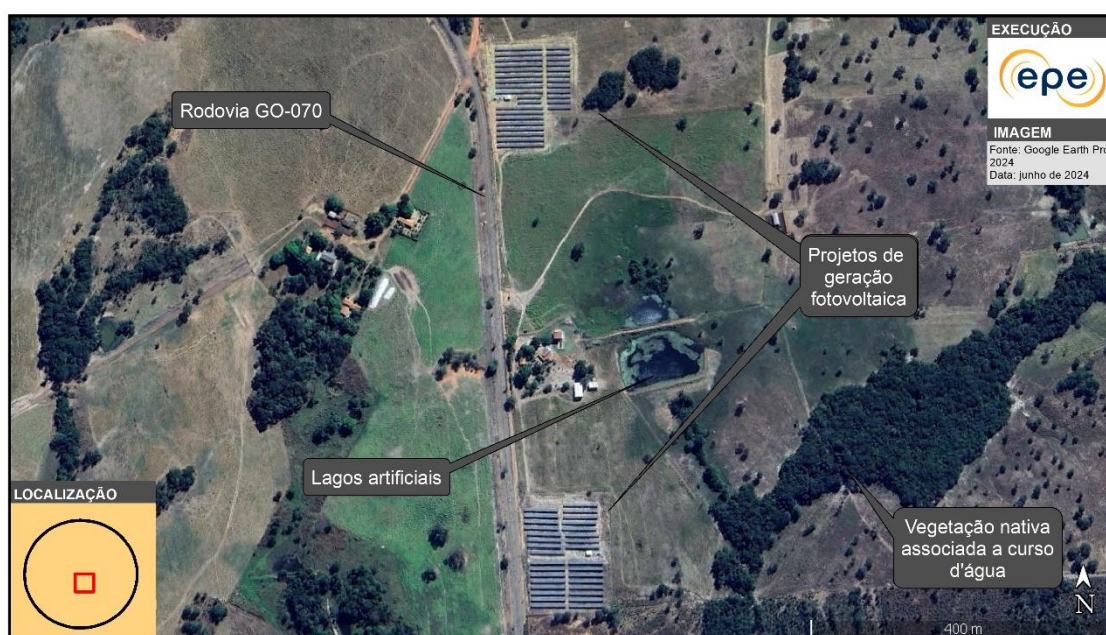
Figura 4 – Projetos de geração fotovoltaica localizados às margens da rodovia GO-070, em trecho à sul da cidade de Matrinchã
