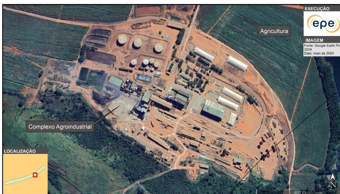
Figura 30 – Complexo agroindustrial com geração térmica a biomassa nas margens da rodovia GO-434
